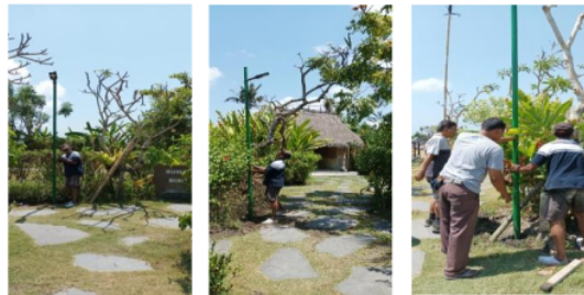
Gambar 1 Penataan dan Pemasangan lampu penerangan jalan tenaga surya
