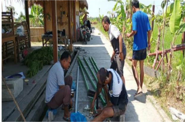
Gambar 2. Pelatihan perakitan lampu penerangan jalan tenaga surya kepada anggota Subak Teba Majelangu
