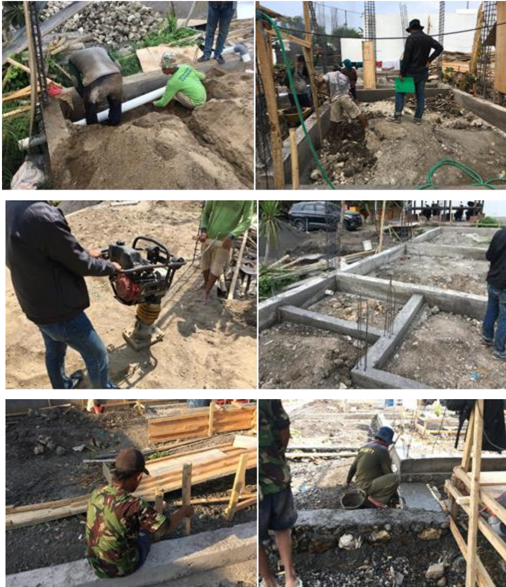
Foto Pekerjaan Villa Kevin.
