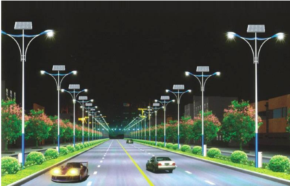
Gambar 2. 2. Lampu Penerangan Jalan Umum Tenaga Surya[10]
