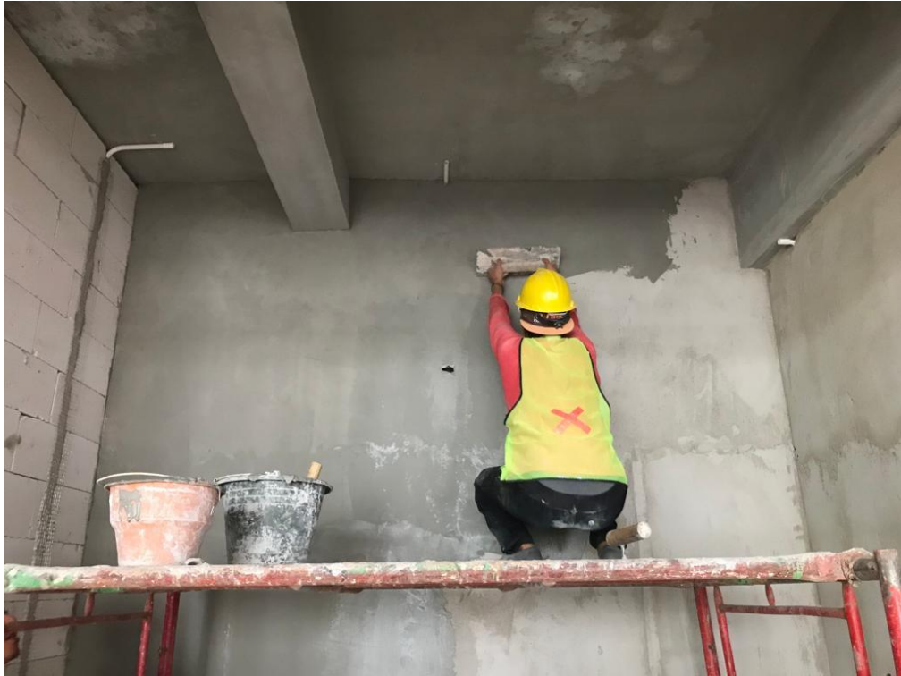
Pekerjaan Acian Dinding
