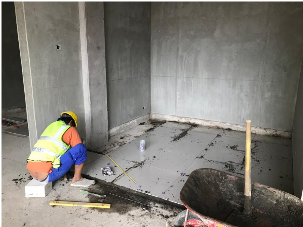
Pekerjaan Pasangan Keramik 60x60 cm
