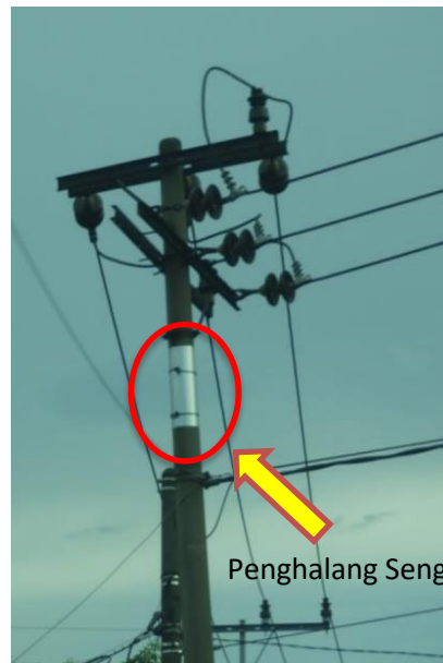
Gambar 1. 2. Pemasangan Seng pada Tiang
