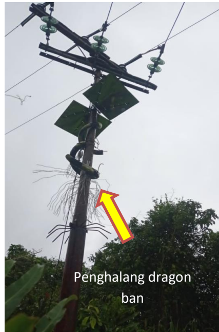
Gambar 1. 3. Pemasangan Dragon Ban pada Tiang
