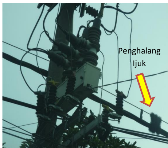
Gambar 1. 4. Pemasangan Ijuk atau Kawat Berduri di JTR
