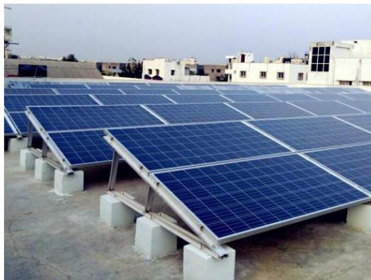
**Gambar 2. 11** Metode Pemasangan *Ballast*<sup>[27]</sup>
