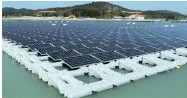
**Gambar 2. 14** Metode Pemasangan *Floating*<sup>[27]</sup>
