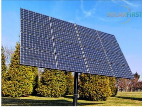
**Gambar 2. 12** Metode Pemasangan *Single Pole*<sup>[27]</sup>
