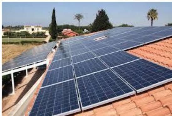
**Gambar 2. 13** Metode Pemasangan *Rooftop Rack*<sup>[27]</sup>
