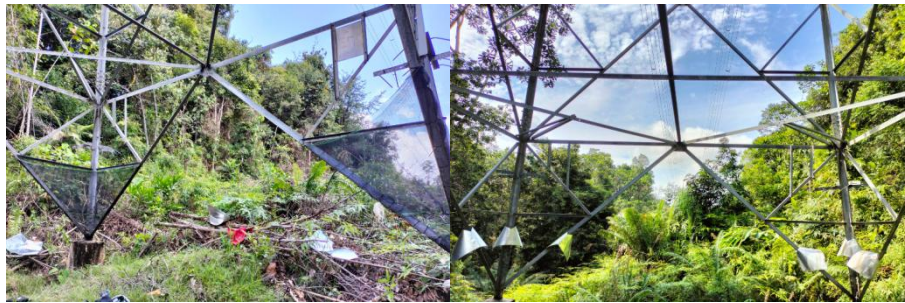
Gambar 1.2 Pemasangan jaring dan corong anti binatang
