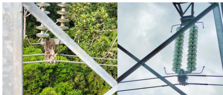
Gambar 1.3 Sarang burung pada suspension clamp
