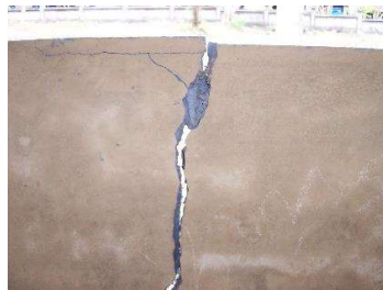
a). Retak vertikal pada tembok rumah
