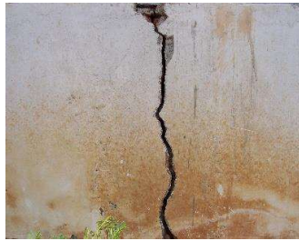
a). Retak vertikal pada tembok rumah
