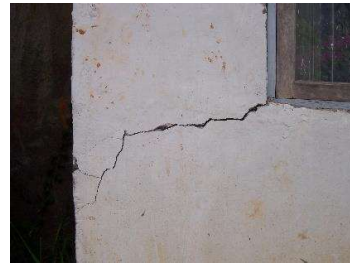
b). Retak pada sudut kusen
