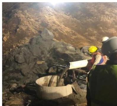
Gambar 4. 6 Pekerjaan Pengecoran Pondasi *Bore Pile*
