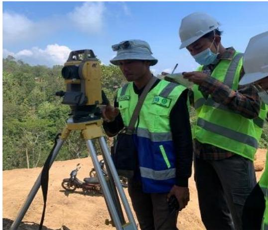
Gambar 4. 3 Pekerjaan Persiapan Penentuan Titik Pengeboran pondasi Menggunakan Alat *Total Station*
