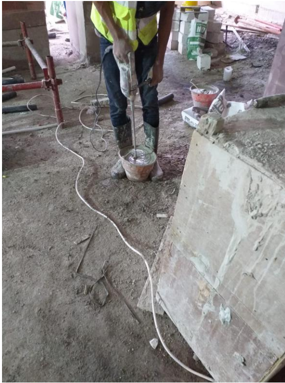
Foto 4. 2 Pembuatan spesi bata ringan
