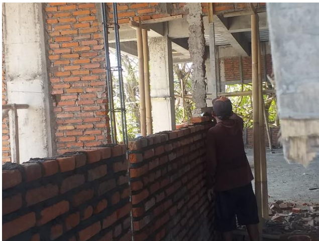
Foto 4. 3 Pemasangan dinding bata merah
