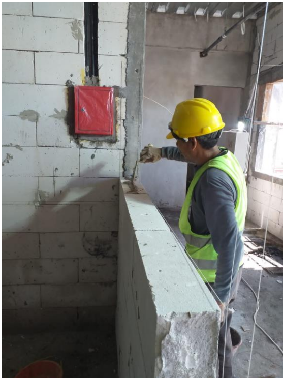
Foto 4. 1 Pemasangan dinding bata ringan
