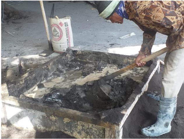
Foto 4. 4 Pembuatan spesi bata merah
