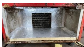
Gambar 10. Menutup celah kondensor
