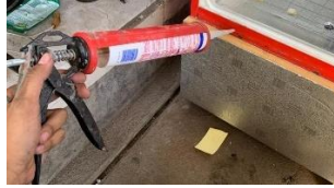
Gambar 11. Mengelem celah-celah yang berlubang
