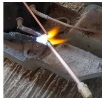
Gambar 5. Pengelasan pipa tembaga
