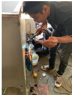
Gambar 12. Perakitan sistem refrigerasi
