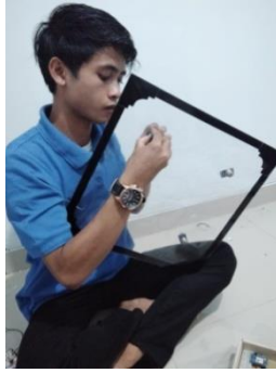
Gambar 12. Proses pemasangan sensor pada ceiling
