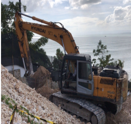
Excavator mengambil tanah
