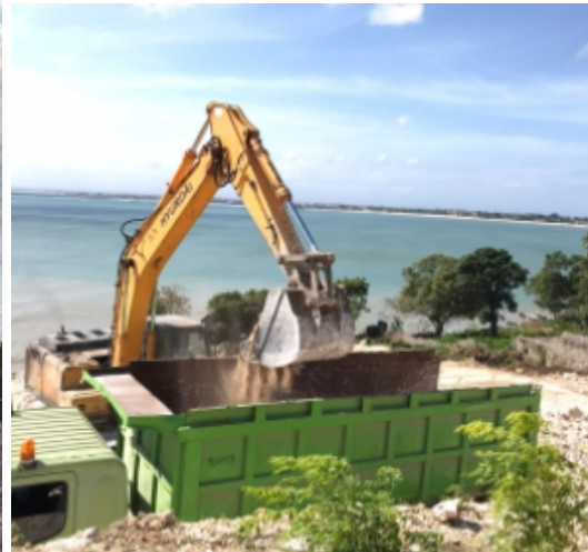
Excavator membuang tanah ke dump truck
