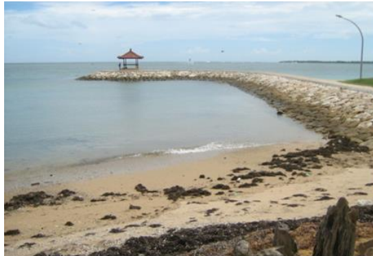
Gambar 1. Pembangunan Crab di wilayah Pantai Sanur
