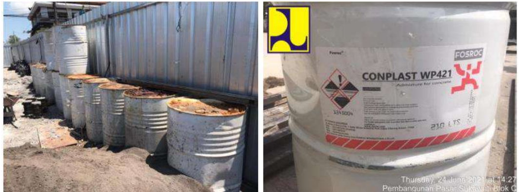
Gambar 4.127 Dokumentasi Penggunaan Material Integral Waterproofing
