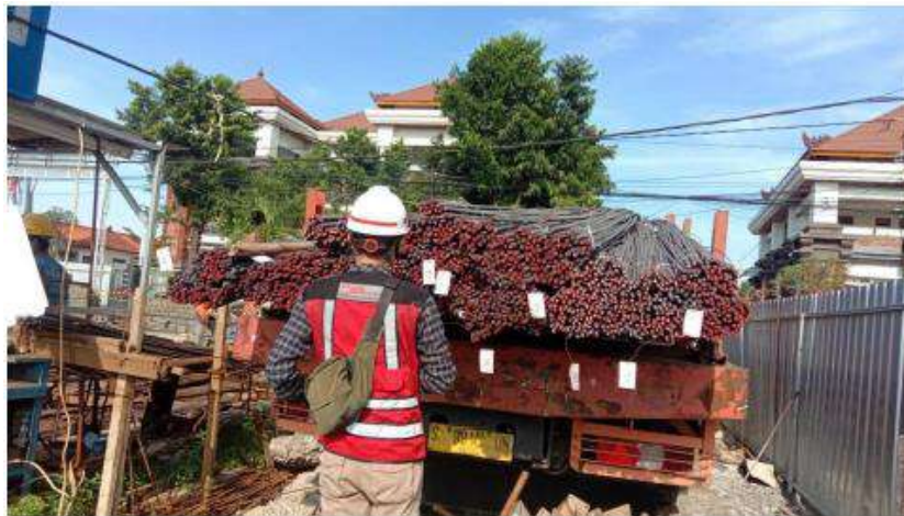
Gambar 4.143 Dokumentasi Kedatangan Material Besi Beton
