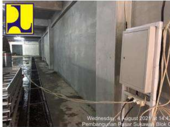
Gambar 4.72 Dokumentasi Pemasangan kWh Meter Panel Distribusi Pada Area Kerja Lantai Basement 2
