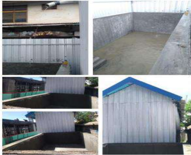
Gambar 4.59. Dokumentasi Penampungan Air Hujan
