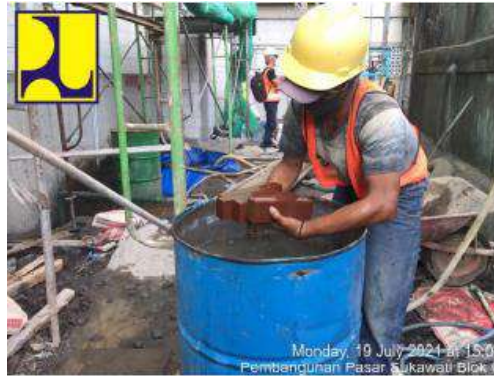
Gambar 4.57. Dokumentasi Pemanfaatan Air untuk Rendaman Bata
