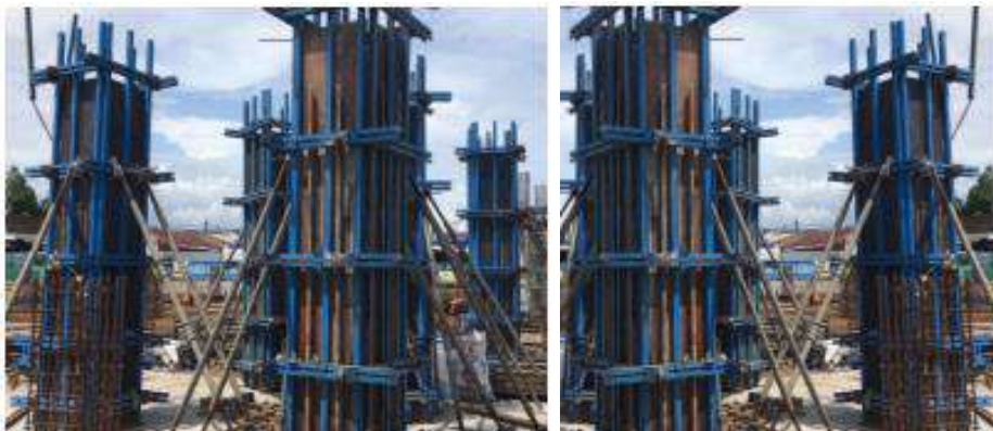
Gambar 4.25. Dokumentasi Penggunaan Bekisting Panel
