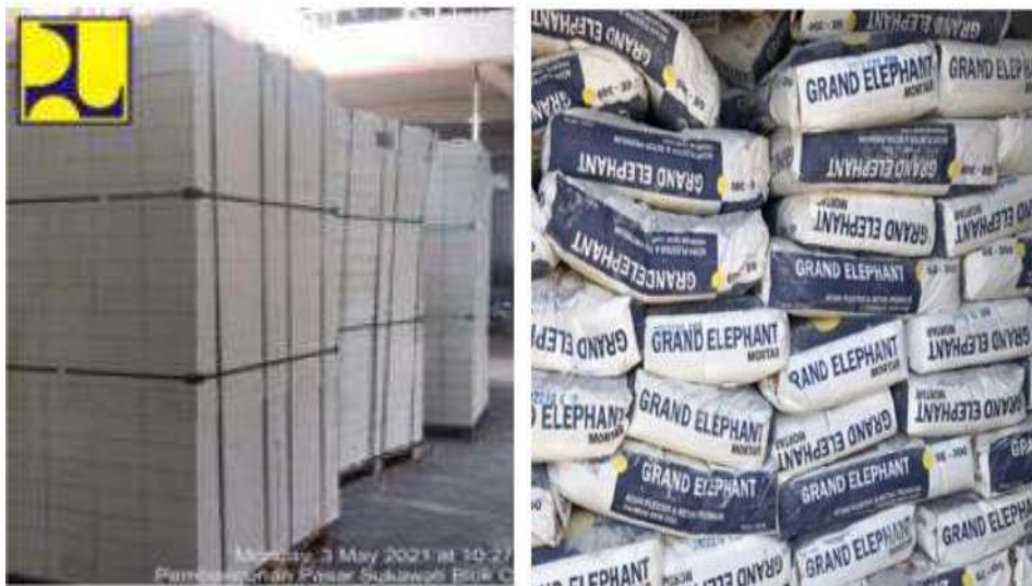
Gambar 4.130 Dokumentasi Penggunaan Material Bata Ringan dan Mortar
