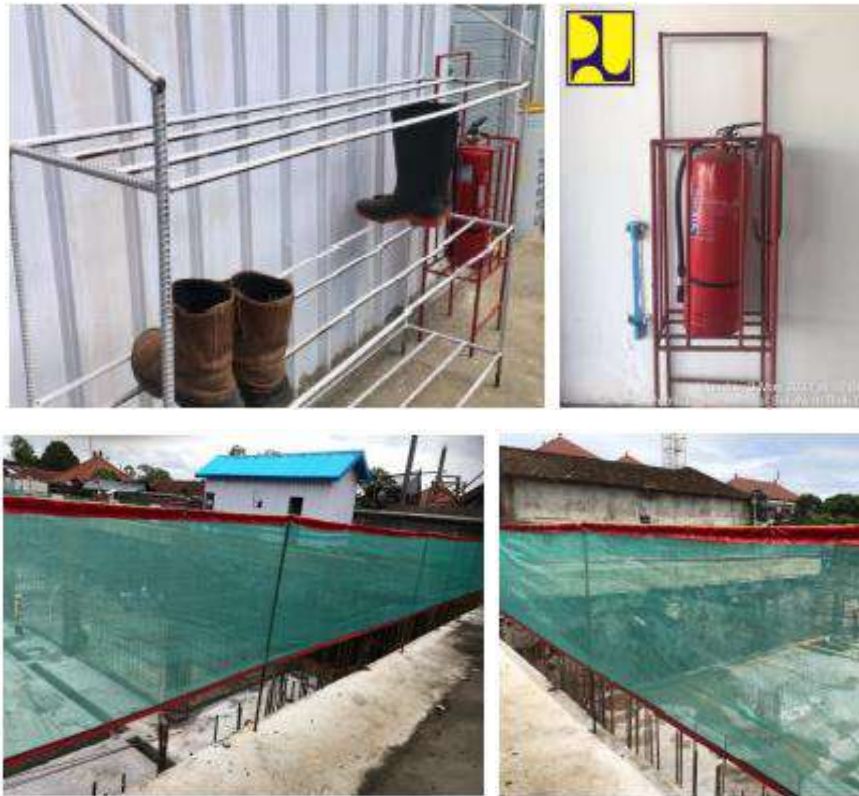
Gambar 4.20. Dokumentasi Pemanfaatan Sisa Potongan Besi
