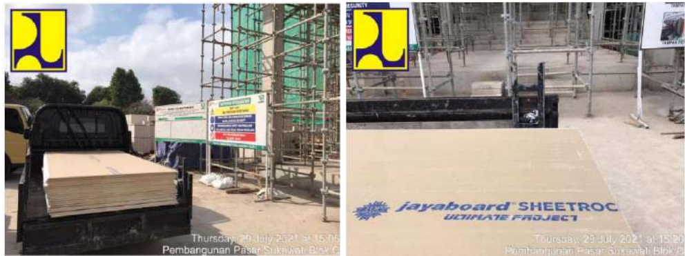
Gambar 4.139 Dokumentasi Material Plafond
