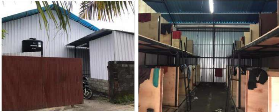
Gambar 4.103 Dokumentasi Mess Pekerja
