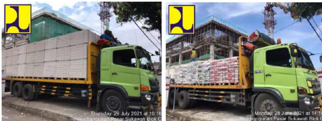
Gambar 4.149 Dokumentasi Kedatangan Material Bata Ringan dan Mortar
