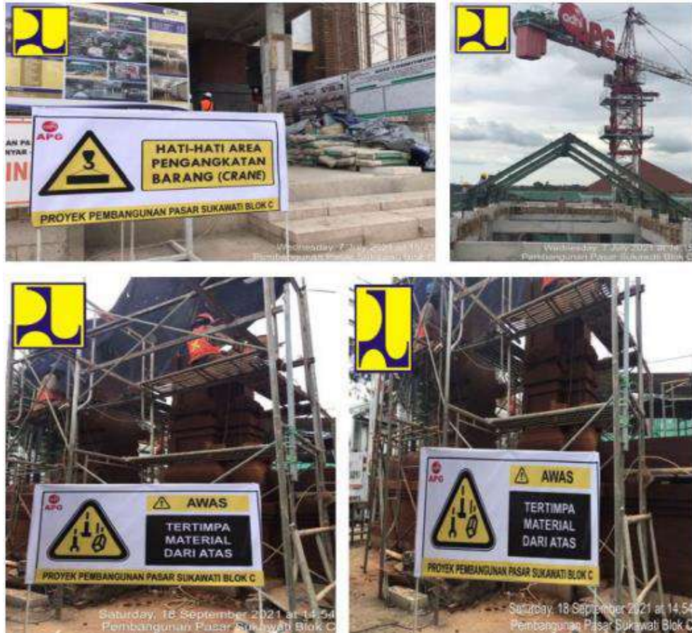
Gambar 4.89 Dokumentasi Pemasangan Rambu-Rambu Peringatan
