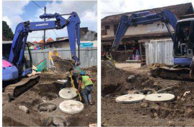
Gambar 4.50. Dokumentasi Titik Sumur Resapan
