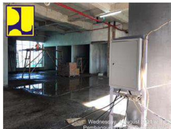
Gambar 4.74 Dokumentasi Pemasangan kWh Meter Panel Distribusi Pada Area Kerja Lantai 2
