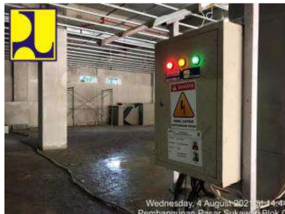
Gambar 4.73 Dokumentasi Pemasangan kWh Meter Panel Distribusi Pada Area Kerja Lantai Basement 1 dan Lantai 1
