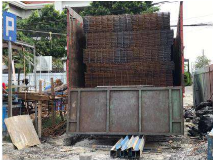
Gambar 4.145 Dokumentasi Kedatangan Material Wiremesh
