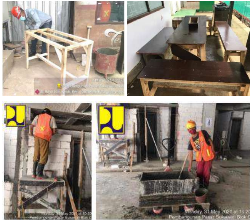
Gambar 4.21. Dokumentasi Pemanfaatan Sisa Potongan Kayu dan Multiplek
