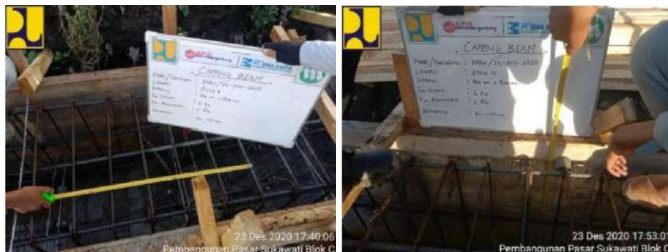
Gambar 4.111 Dokumentasi Penggunaan Capping Beam
