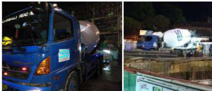
Gambar 4.124 Dokumentasi Penggunaan Material Beton
