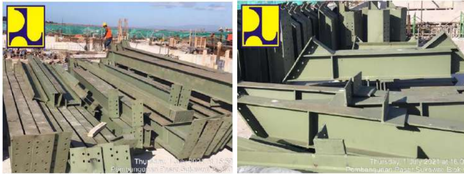
Gambar 4.147 Dokumentasi Kedatangan Baja WF
