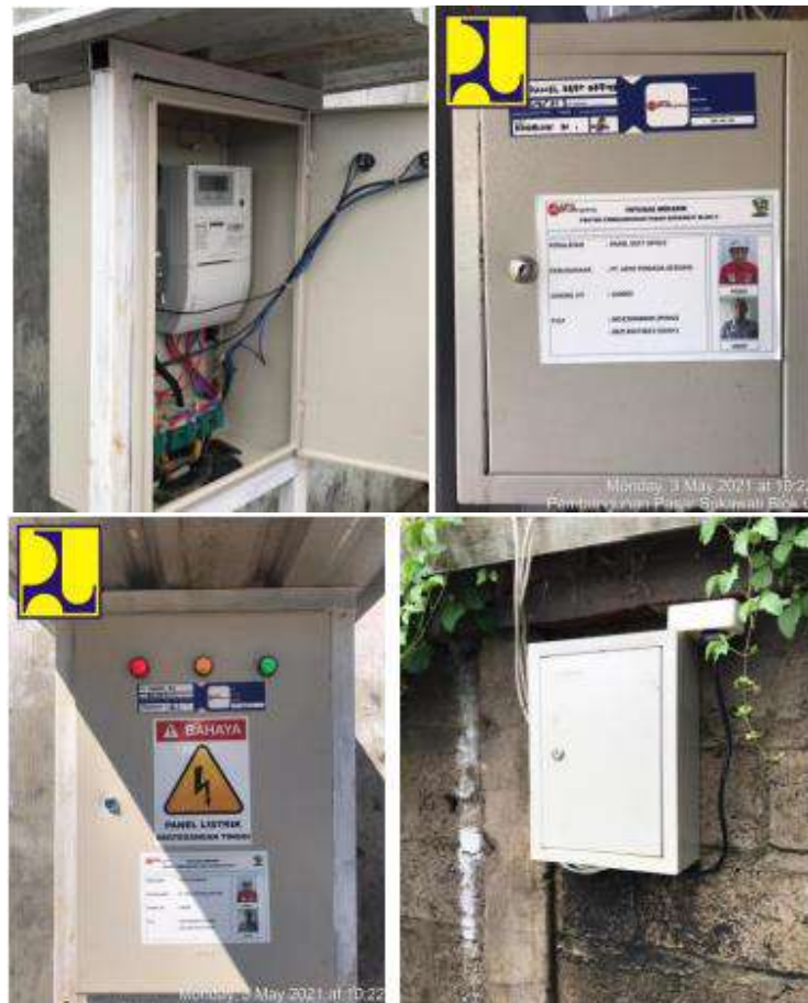
Gambar 4.71 Dokumentasi Pemasangan kWh Meter Panel Distribusi Pada Area Kerja Luar Gedung
