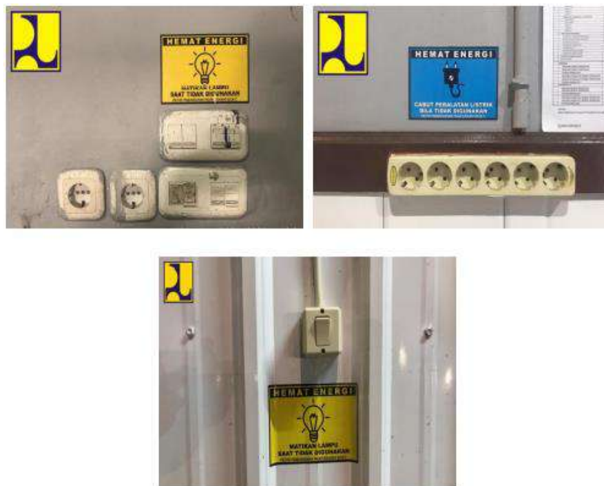
Gambar 4.65 Dokumentasi Pemasanan Sign Hemat Energi
