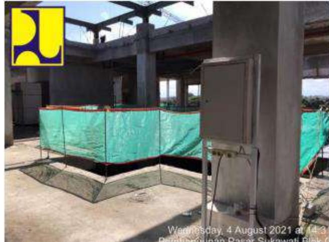
Gambar 4.75 Dokumentasi Pemasangan kWh Meter Panel Distribusi Pada Area Kerja Lantai 3
