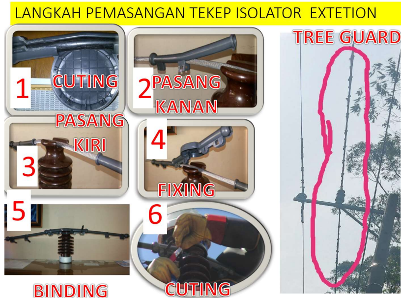
Gambar 15 Langkah-Langkah Pemasangan Tekep Isolator Extention
