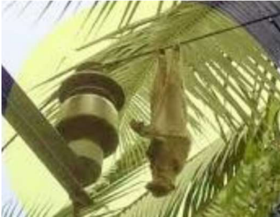
Gambar 12. Gangguan Satu Phasa Ke Tanah Karena Klelawar
