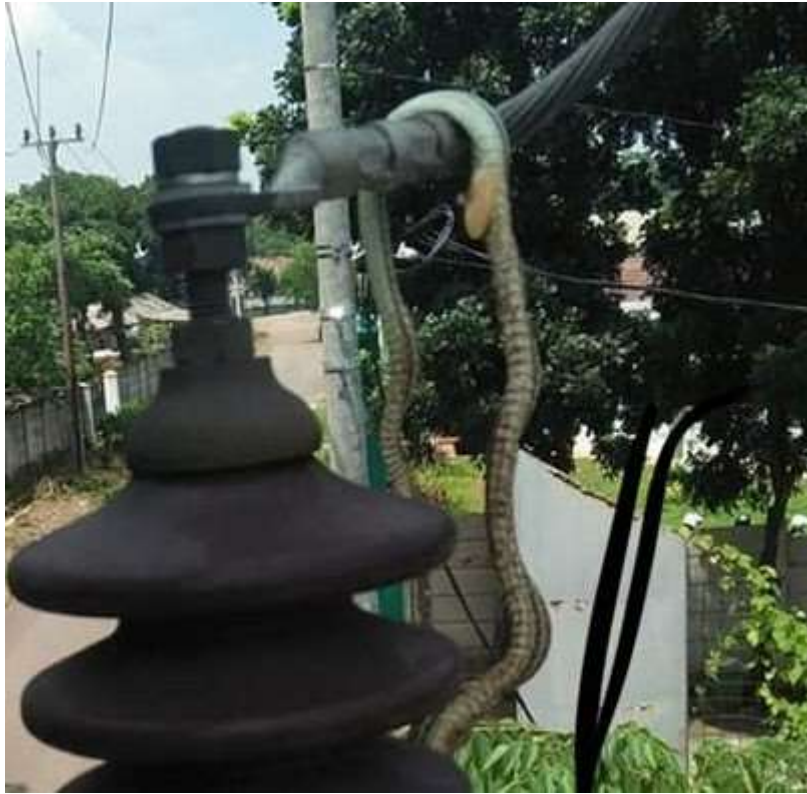
Gambar 14 Gangguan Satu Fasa ke Tanah Karena Ular
