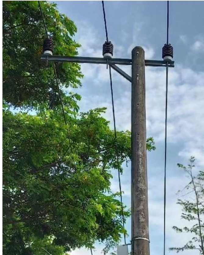
Gambar 11 Gangguan 1 Fasa Ke Tanah Akibat Pohon
