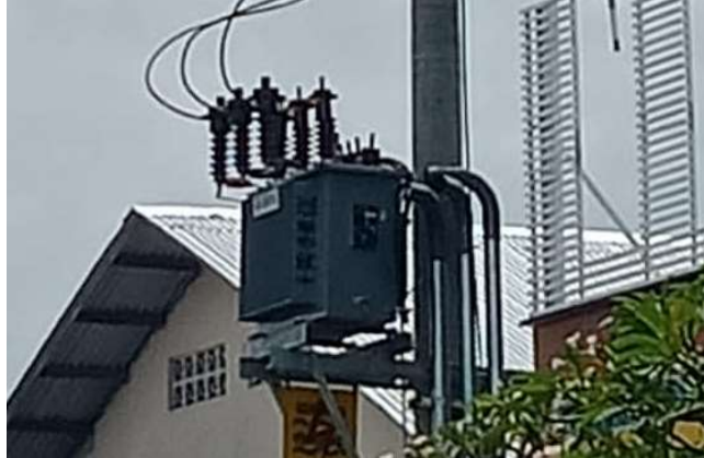
Gambar 15 Pemasangan Tekep Isolator Bushing trafo dan arrester
