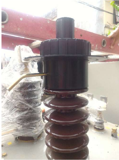
Gambar 15 Tekep Isolator YS-BUS-ARR-70-140AP Dipasang di Bushing Trafo
