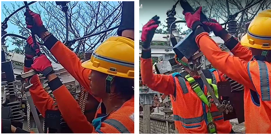
Gambar 14 Langkah-Langkah Pemasangan Tekep Isolator Gardu
