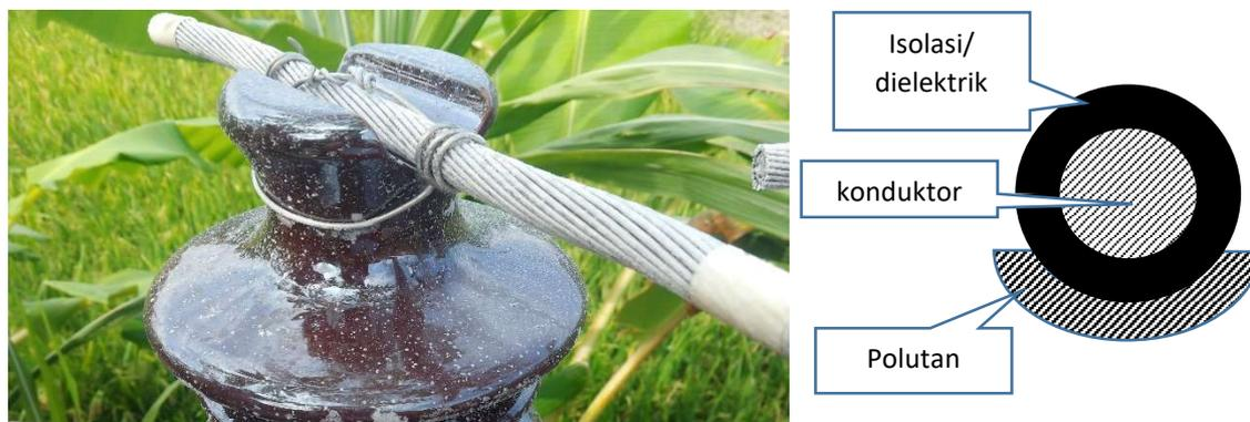
Gambar 10 Isolator Tumpu Berpolutan dan Ilustrasi Kapasitansi
