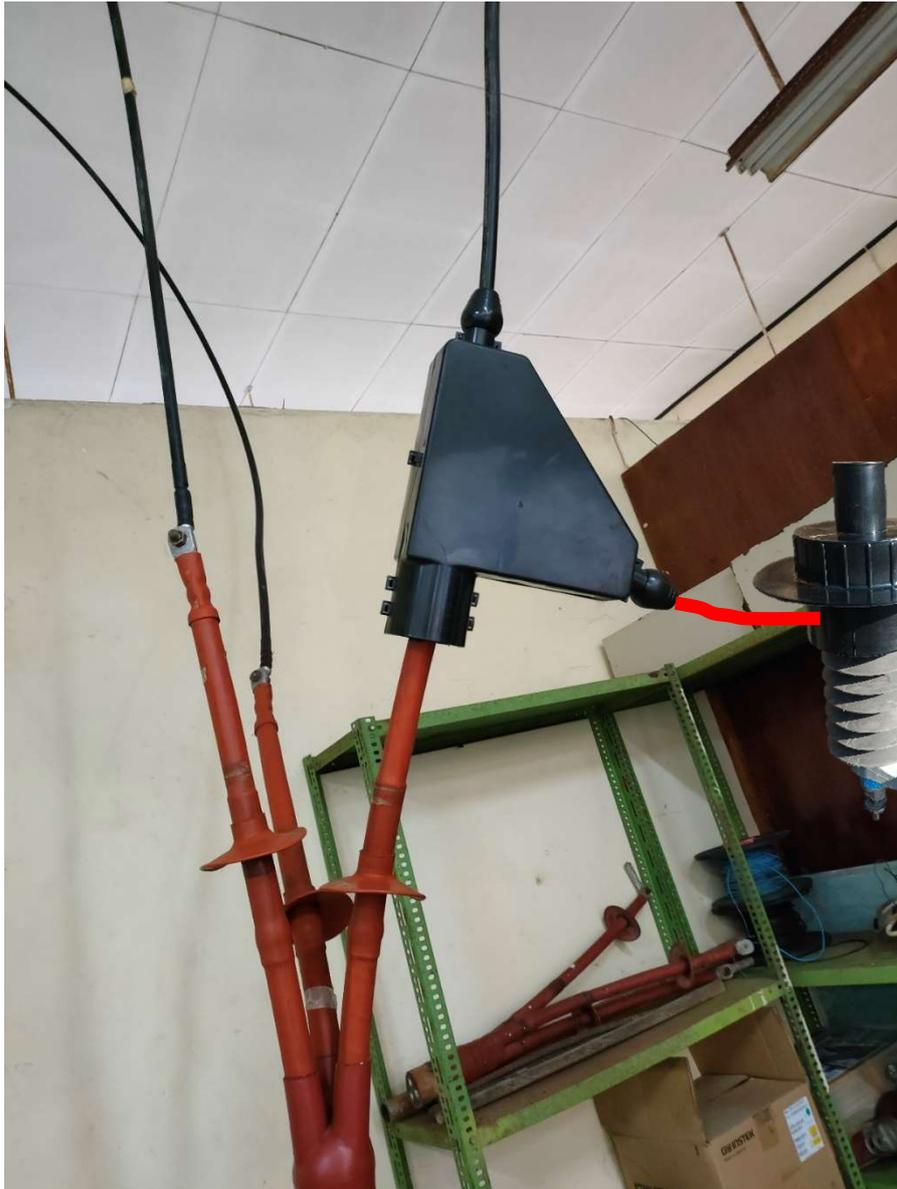
Gambar 18 Langkah-Langkah Pemasangan Tekep Isolator Strain Clamp Pada Terminating MVTIC atau Kabel Tanam
