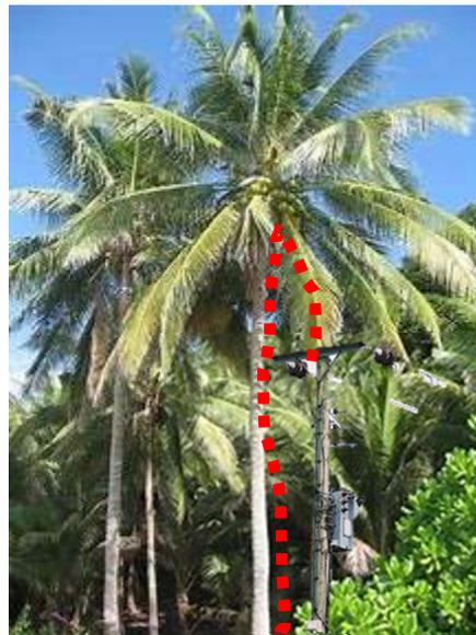
Gambar 14 Ilustrasi Gangguan Satu Fasa ke Tanah Karena Pohon Kelapa
