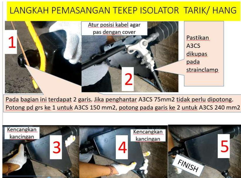
Gambar 16 Langkah-Langkah Pemasangan Tekep Isolator Strain Clamp
