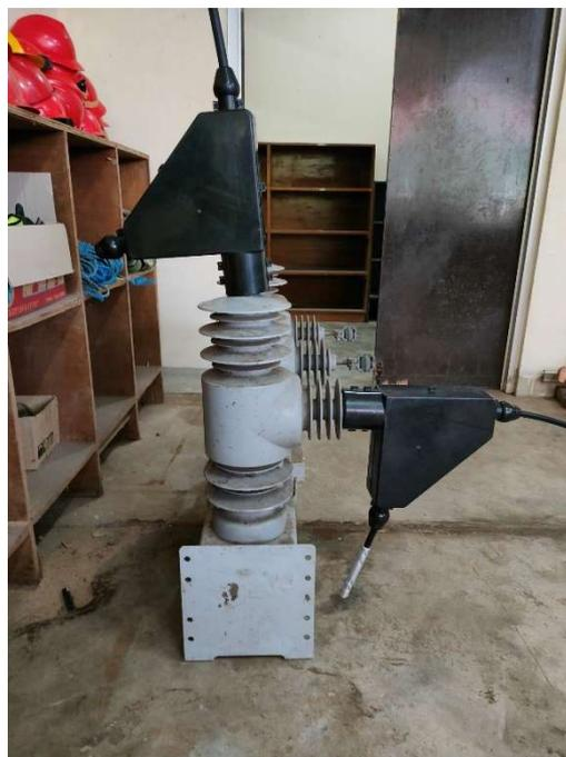
Gambar 17 Langkah-Langkah Pemasangan Tekep Isolator Strain Clamp Pada Recloser
