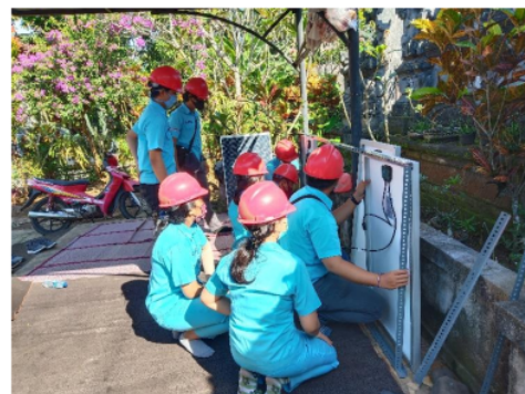
Gambar 5. Mahasiswa Sedang Merakit Pemasangan Panel Surya
