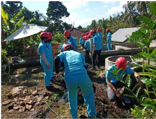
Gambar 7. Penanaman Kabel Power Dan Pemasangan Panel Control
