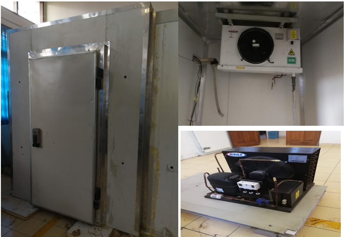
Gambar 3. Sebagian foto pada proses pemasangan indoor dan outdoor dari cold storage
