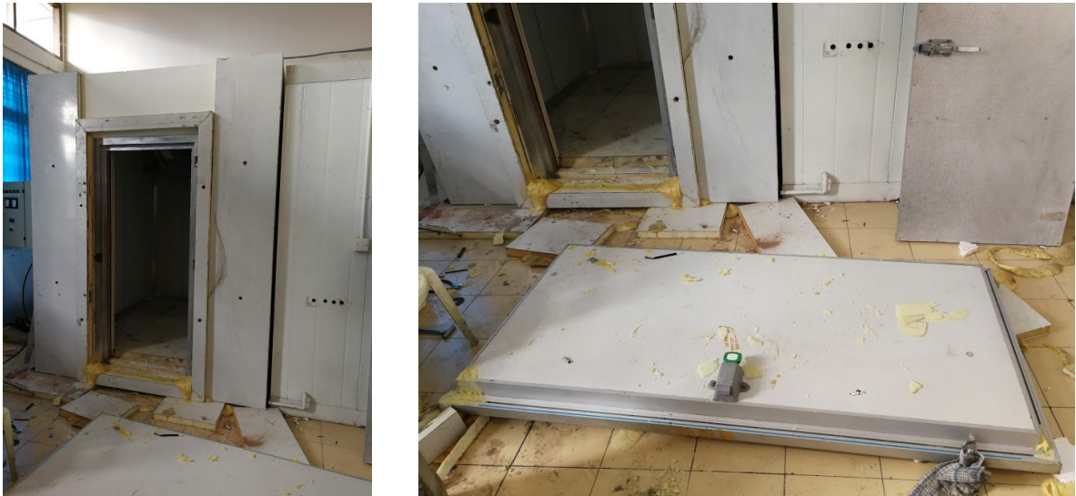
Gambar 2. Sebagian foto tahapan konstruksi dinding panel cold storage dan pintunya
