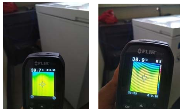
Gambar 1.11 Pengukuran temperatur kondensasi thermal image camera
