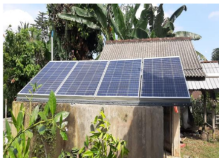
Gambar 3. Pemasangan Panel Surya
