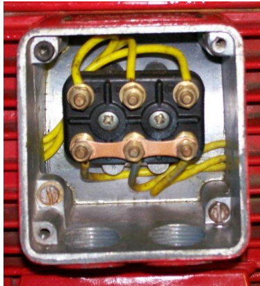
Gambar 2. Box terminal motor induksi 3 fasa
