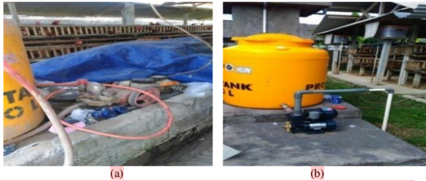
Gambar 1. (a) Sebelum Penggantian Profil Tank dan Pompa, (b) Sesudah Penggantian
