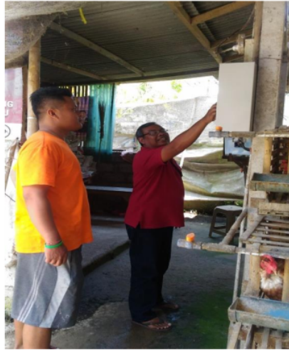
1 Gambar 5. Pelatihan Mengoperasikan Panel Pompa
