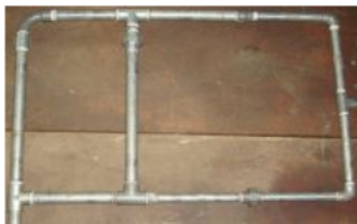
Gambar 5 Perakitan Instalasi Pipa Tertutup
