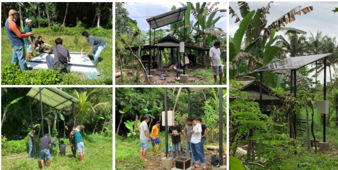
Gambar 2. Pemasangan PLTS 1KW di lokasi yang telah dibersihkan
