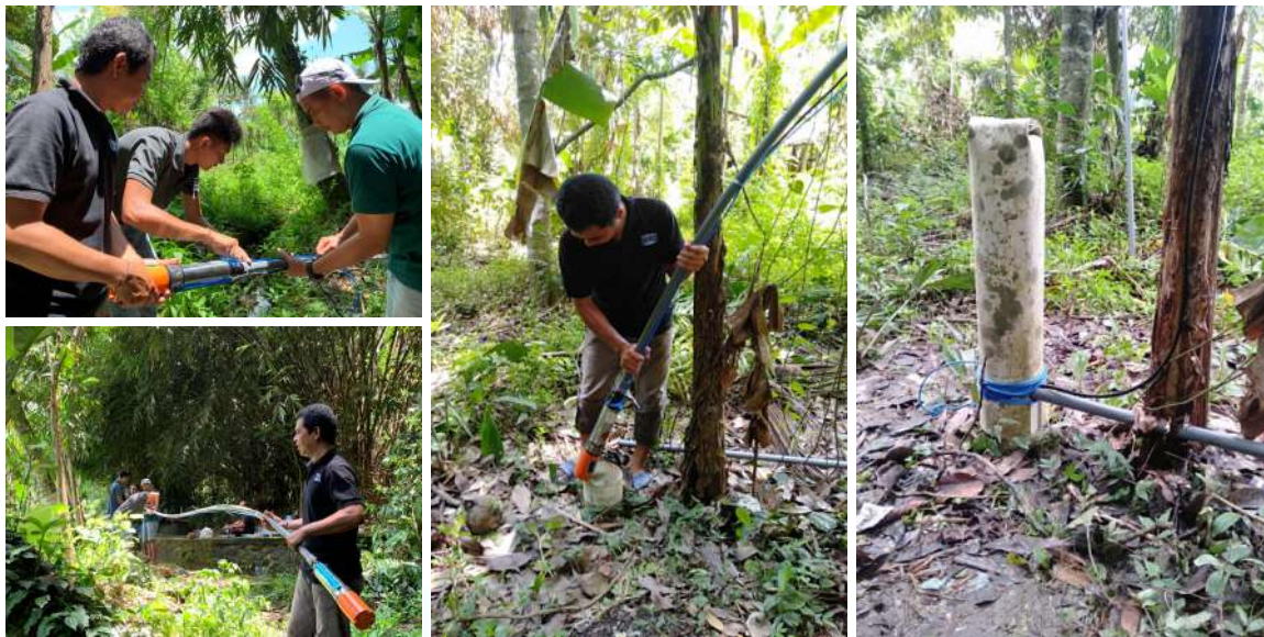
Gambar 3. Pemasangan pompa submersible ke dalam sumur bor
