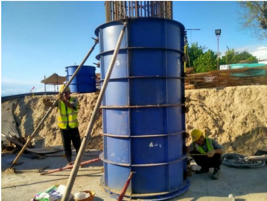
PEKERJAAN PEMBETONAN KOLOM
