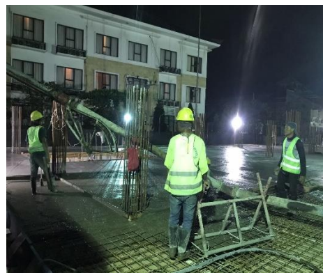
Pekerjaan Pengecoran
