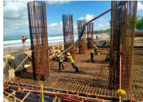
Gambar Pengecoran Pondasi Raft Disisi Bagian Selatan
