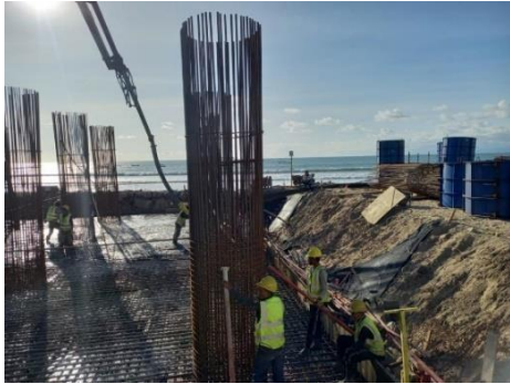
Gambar Pengecoran Pondasi Raft Disisi Bagian Utara
