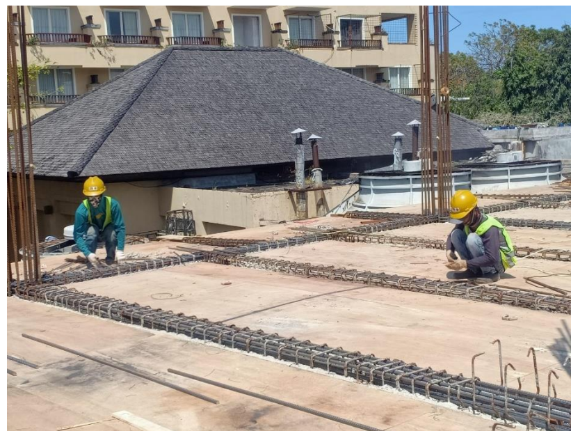
Pekerjaan Pembesian diatas Balok
