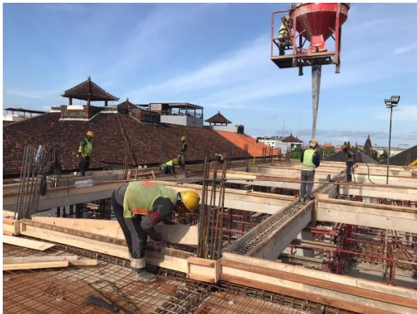
Pekerjaan Pengecoran
