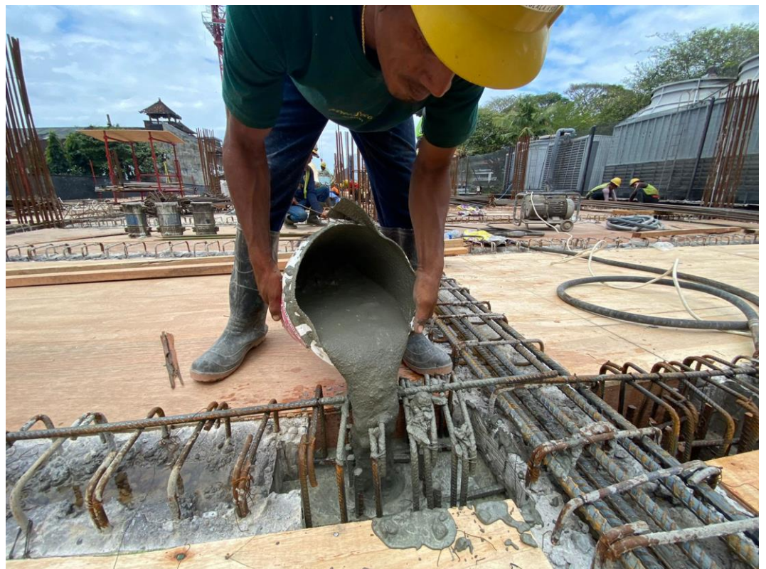
Pekerjaan Pengecoran Sambungan
