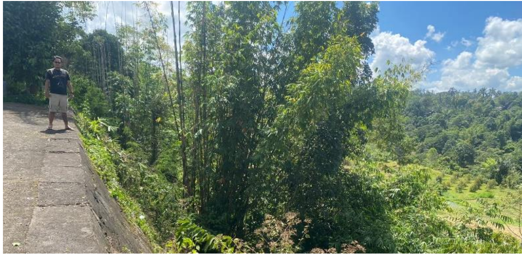
Gambar 1. 2 Perkuatan Lereng Beton di Desa Sandakan
