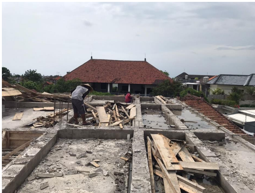
Dokumentasi proses pembongkaran bekisting
