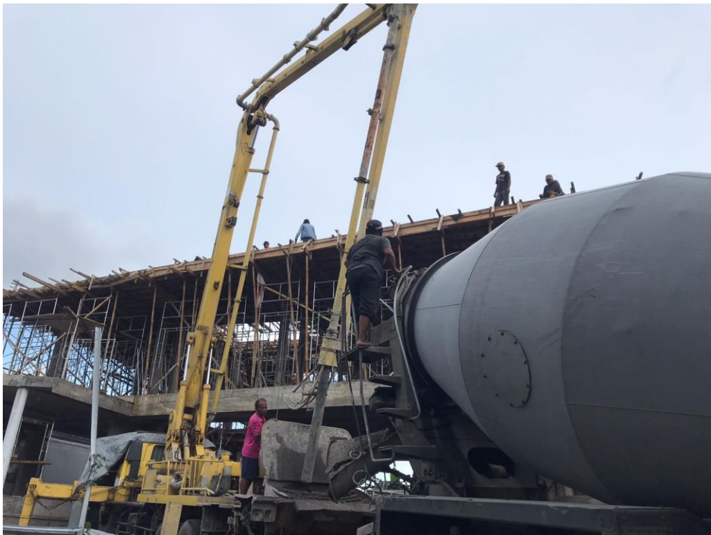
Dokumentasi concrete pump dan truck mixer
