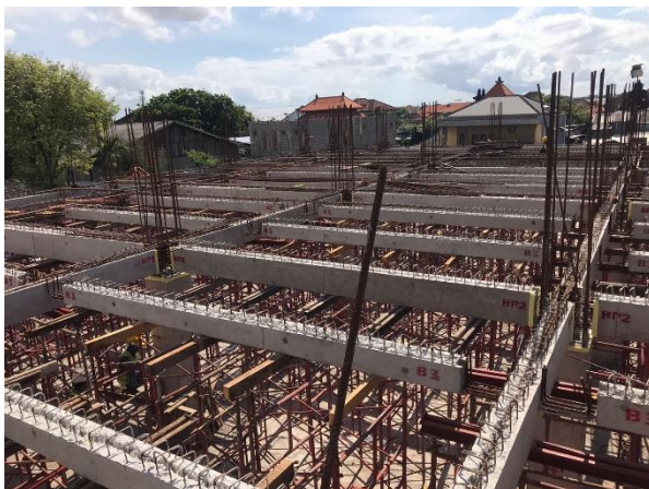
Pemindahan balok precast
