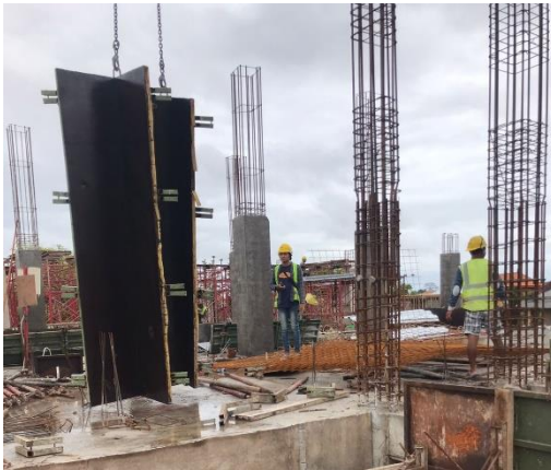
Pembongkaran bekisting kolom
