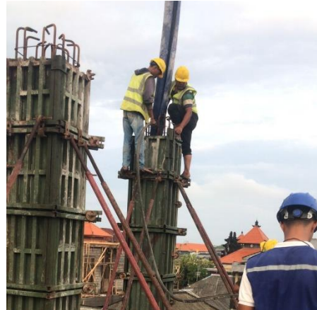
Pengecoran kolom
