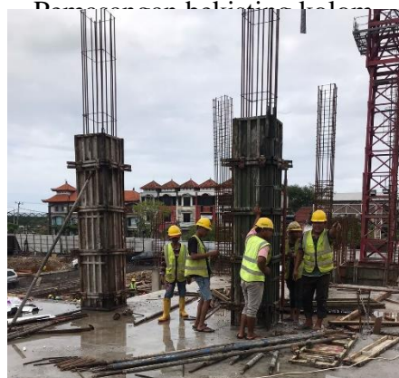
Pemasangan bekisting kolom
