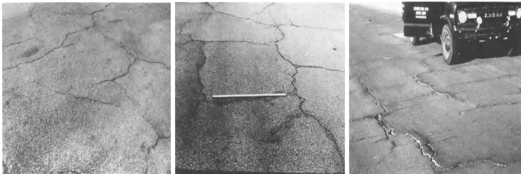
Gambar 2. 6 Retak kotak-kotak(L,M,H)
