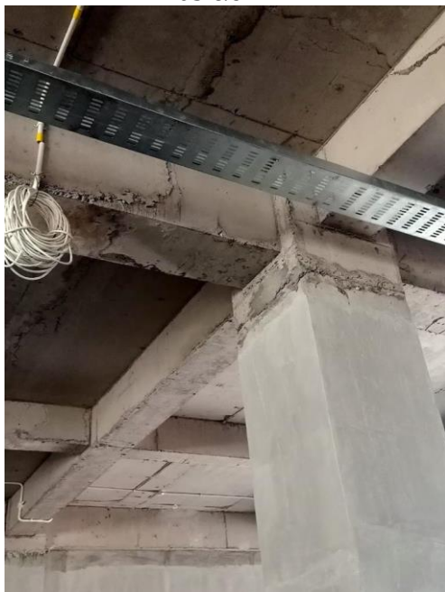
Bleberan beton pada balok B1 as 3/H-I
