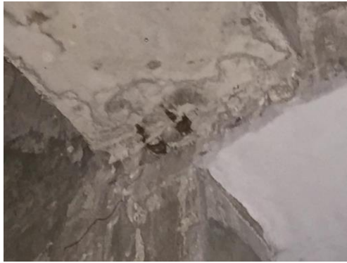
Sisa Tie Rod pada balok B3 3-4/F-G
