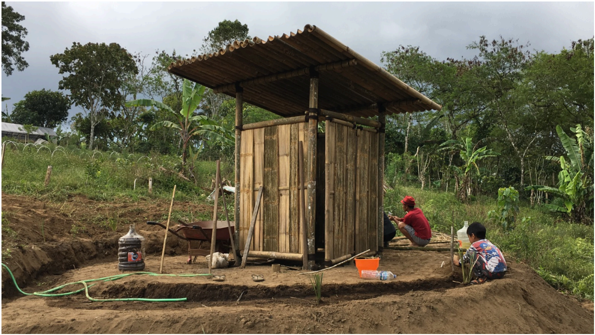
Pengerjaan Toilet Ramah Lingkungan
