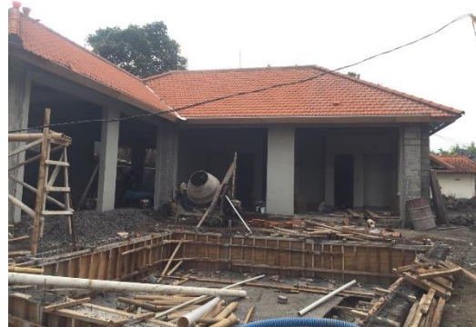
Gambar 1.11 Situasi Proyek Villa Kemboja
