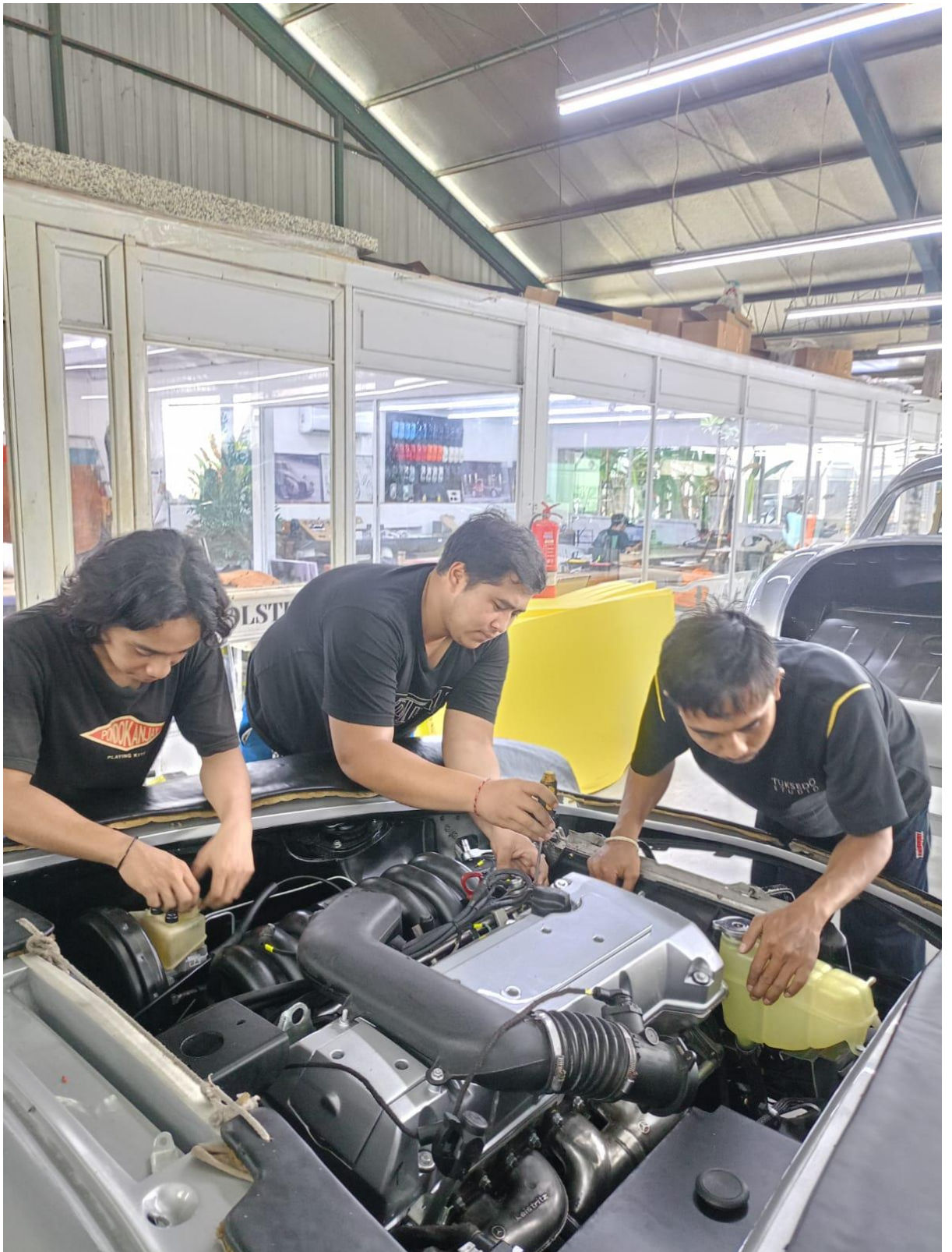
Lampiran 3 Pengencangan klem selang radiator
