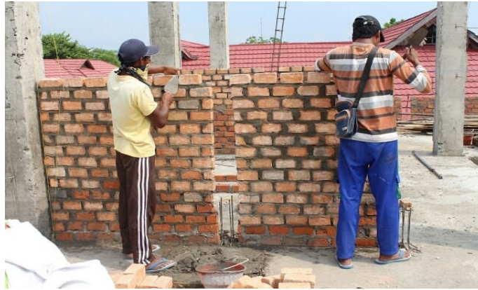
Pemasangan bata merah lantai 2
