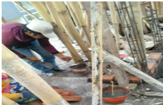
Pemasangan bata merah lantai 1
