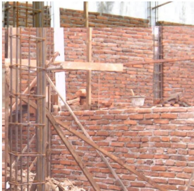
Gambar 4. 2 Pasangan bata merah
