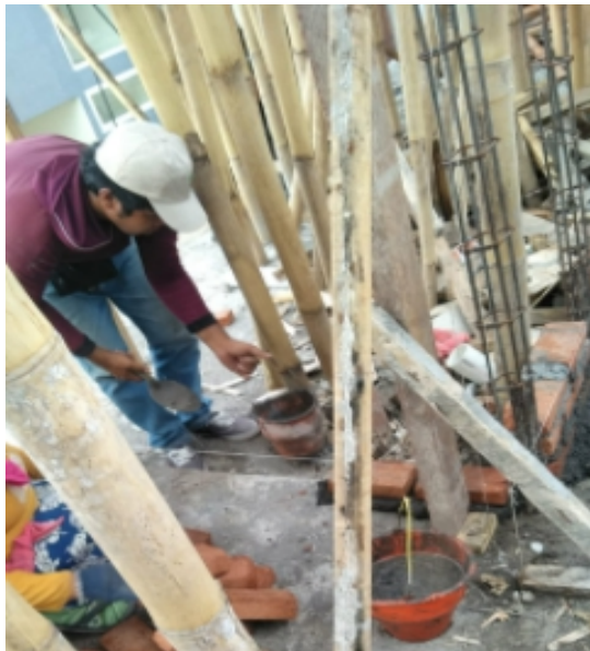
Gambar 4. 1 Pemasangan Bata
