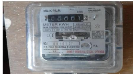
Gambar 1. kWh meter analog
