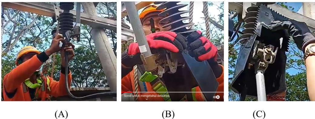
Gambar 14 Langkah-Langkah Pemasangan Tekep Isolator Incoming FCO
