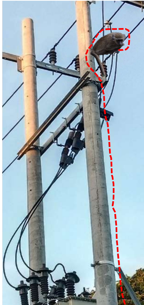
Gambar 11 Ilustrasi Gangguan 1 Fasa Ke Tanah Akibat Monyet Pada LLC Gardu Portal
