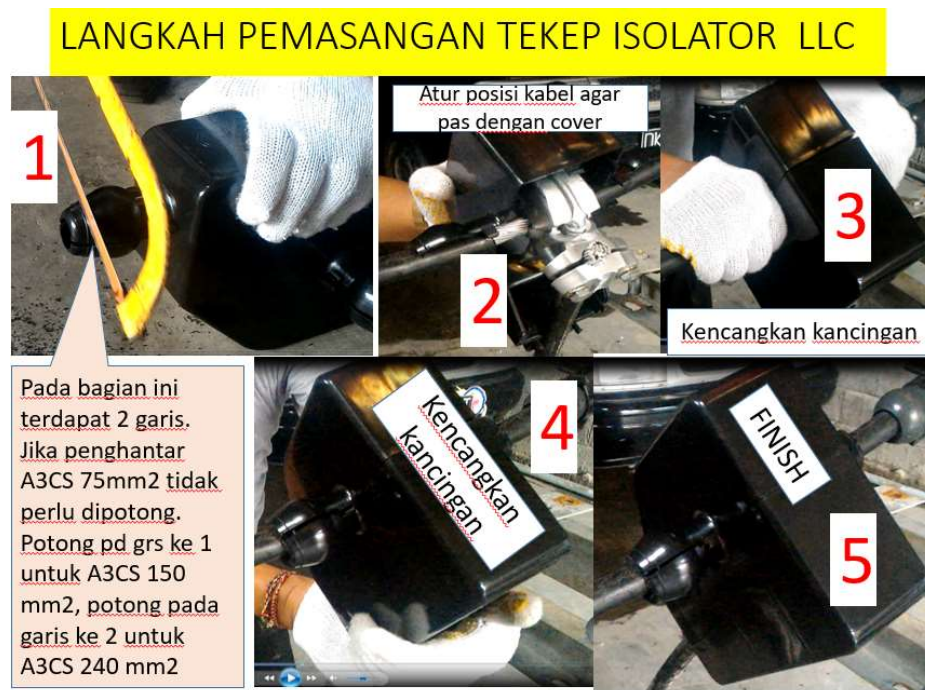
Gambar 14 Langkah-Langkah Pemasangan Tekep Isolator Connector
