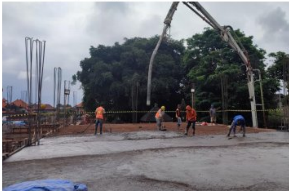
Gambar 4.9 Pengecoran Pelat Lantai
