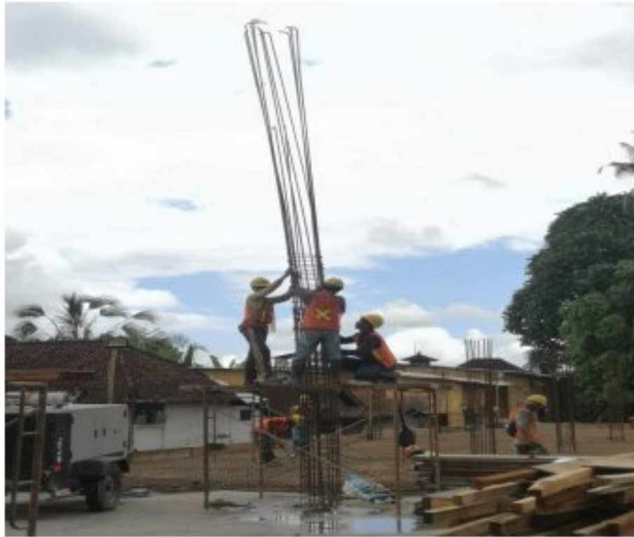
Gambar 4.4 Penulangan Kolom
