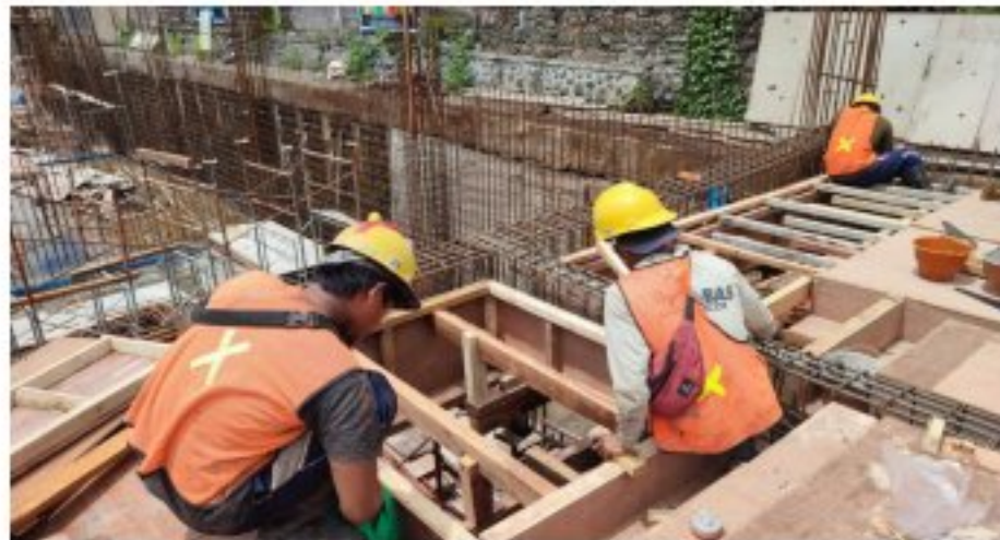
Gambar 4.3 Pemasangan Bekisting Pelat Lantai
