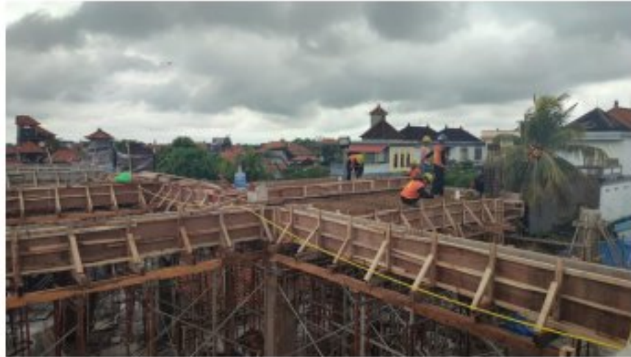
Gambar 4.2 Pemasangan Bekisting Balok
