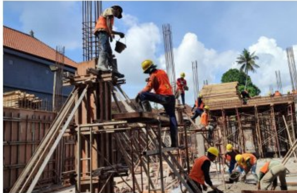
Gambar 4. 7 Pengecoran Kolom
