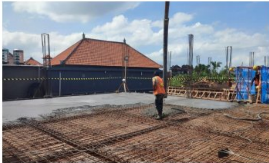
Gambar 4.8 Pengecoran Balok
