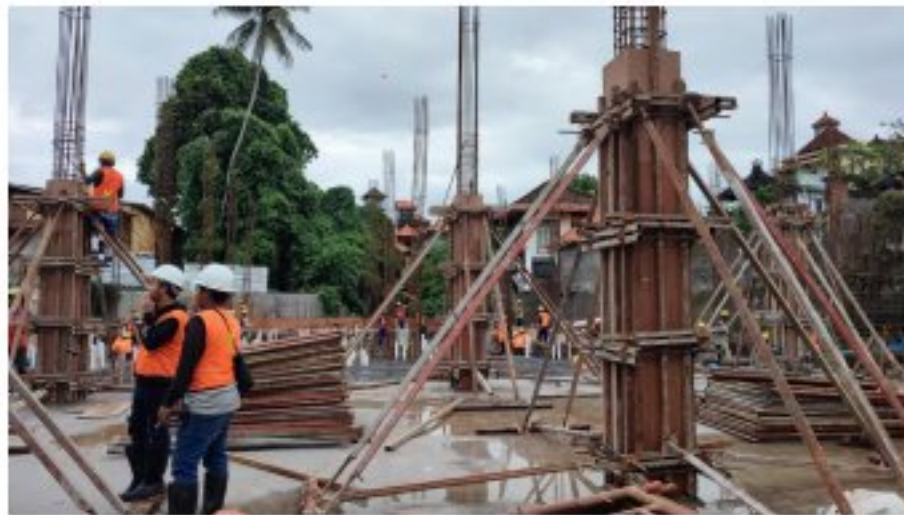
Gambar 4.1 Pemasangan Bekisting Kolom
