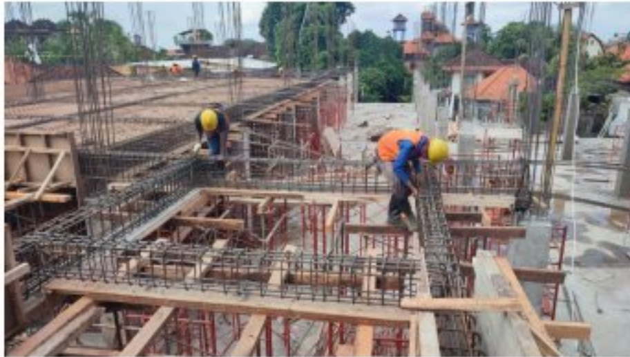
Gambar 4.5 Penulangan Balok
