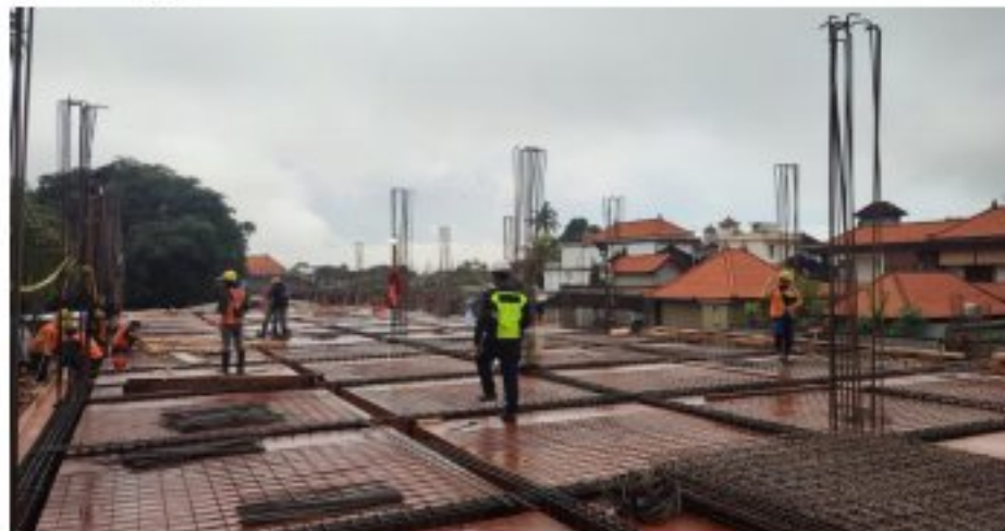
Gambar 4.6 Penulangan Pelat Lantai
