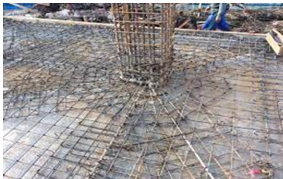
Gambar 2.2 Pondasi konstruksi sarang laba-laba
